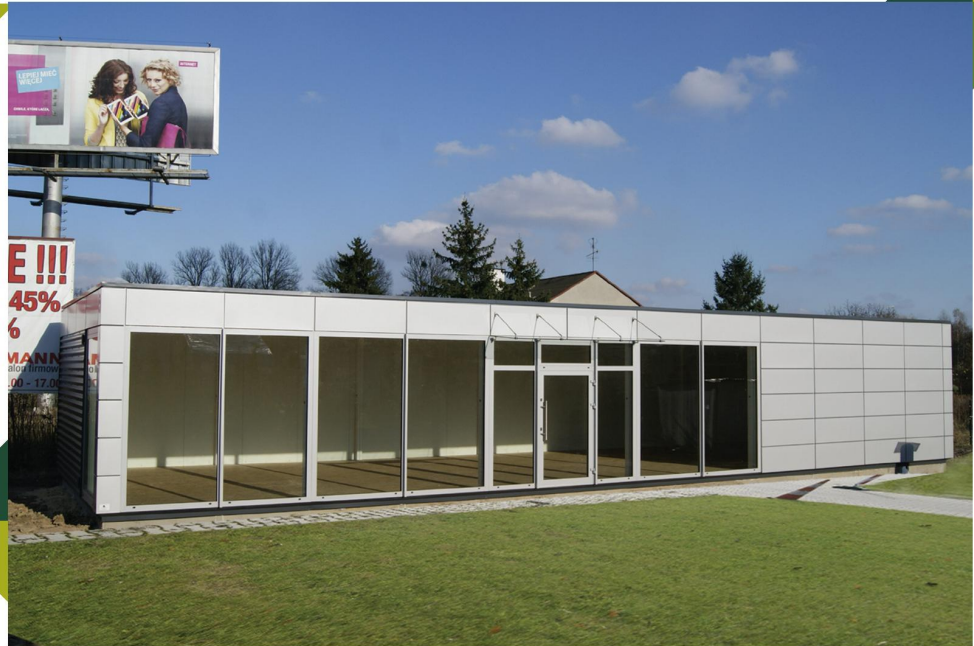
Pavillon Serie Zez mit einer Fassade gebaut aus Stahlkassetten im symmetrischer Layout
