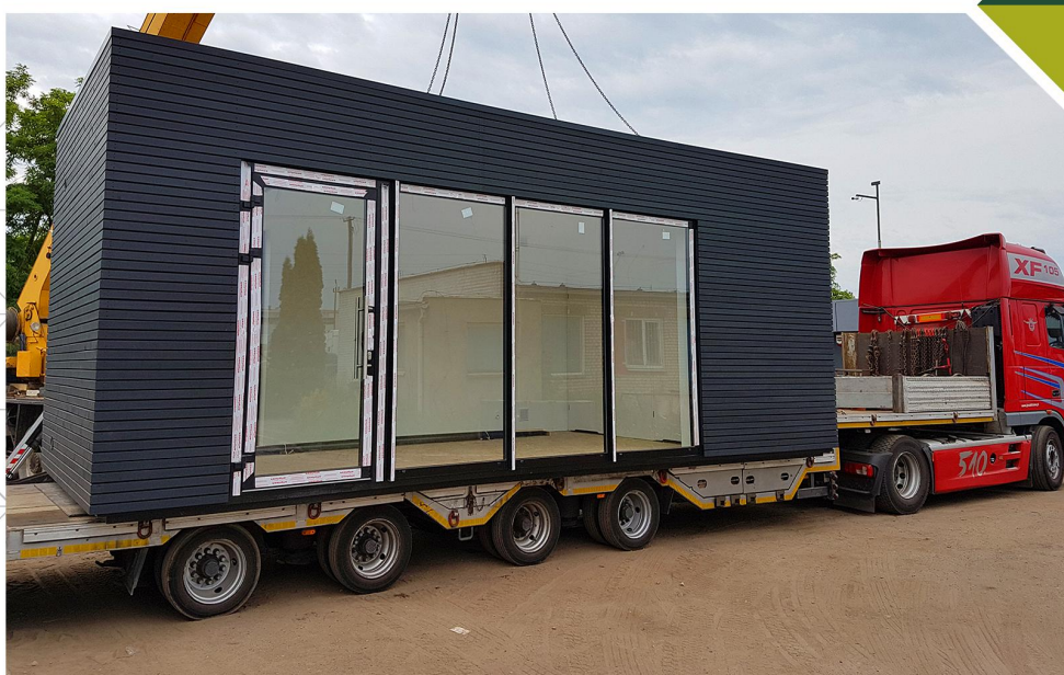
Fassade gebaut aus Holz
