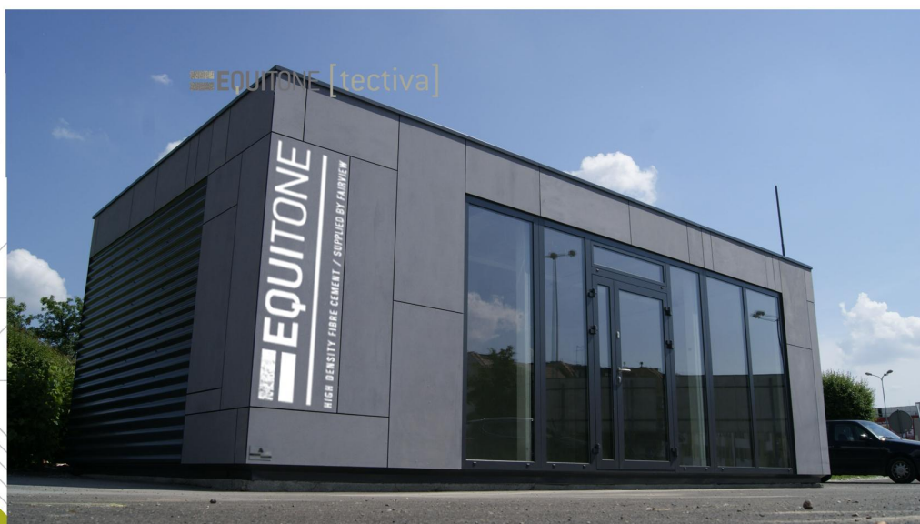
Fassade gebaut aus Tectiva Fasserzementplat- ten im eine irregulär Layout
