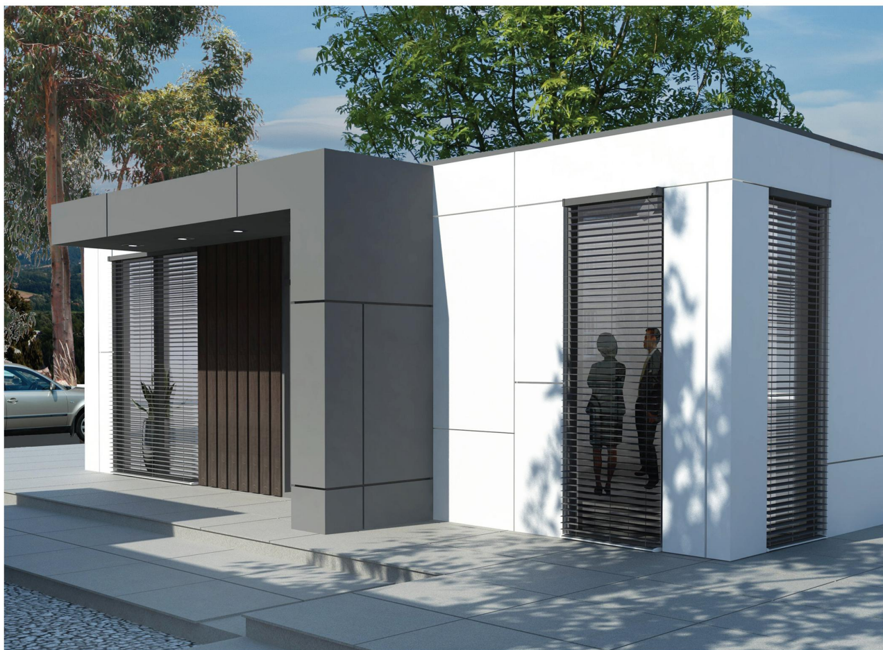
Pavillon Serie Zez - Pro mit einer moderner Fassade gebaut aus Fasserzementplatten
