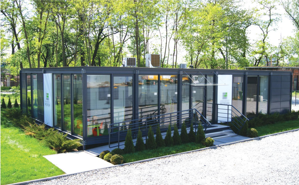
Fassade gebaut aus Stahlkassetten
